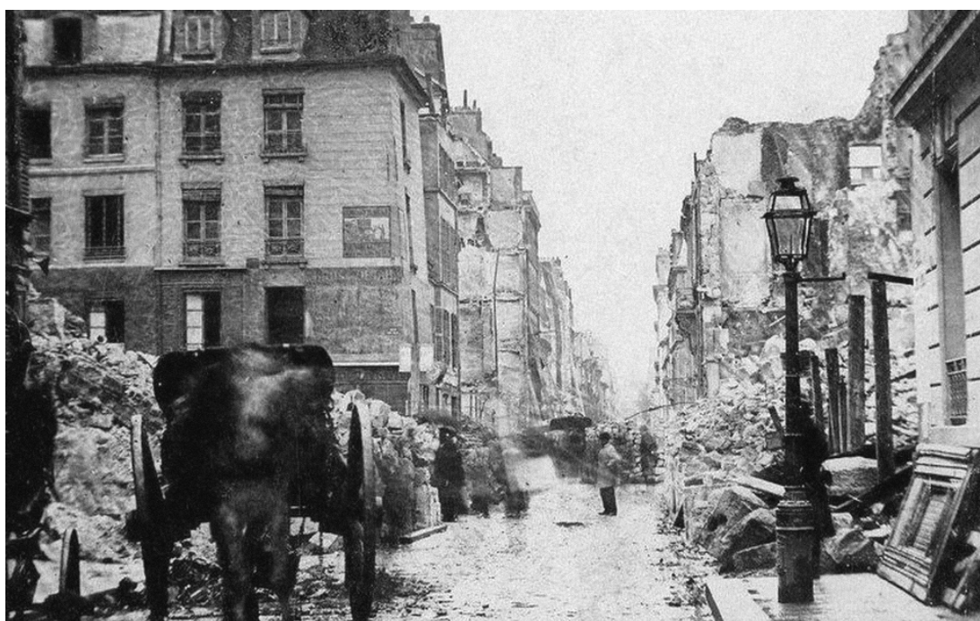
[Rue de Paris, détruite après la Commune | DR]
