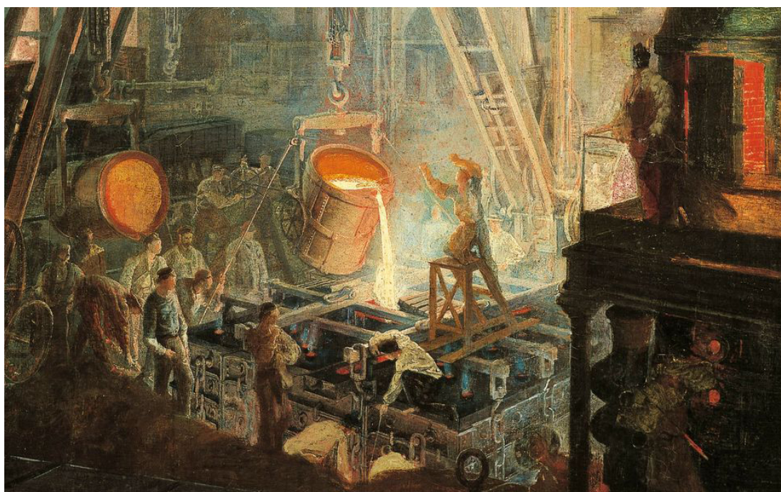
□J.-F. Bonhomme, Fonderie à Indret ou Coulée de fonte , 1864□
